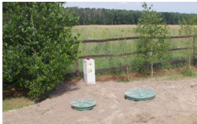
Zakopana oczyszczalnia SBR Primo+ ze standardowymi pokrywami
