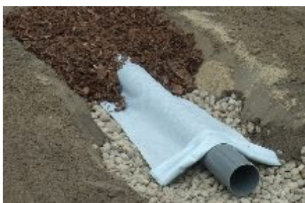
Warstwy pochłaniacza ro linnego
