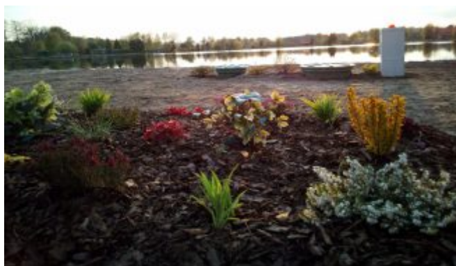
Oczyszczalnia SBR Primo+ z poletkiem ro linnym
