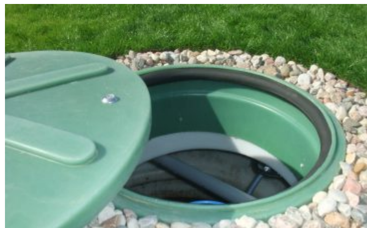
Zakopany moduł SBR Primo+
