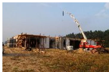
Budowa nowoczesnej siedziby wraz z halą (2008r.)
