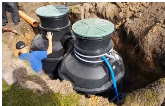
Super SBR TYTAN 6 (w wykopie)
