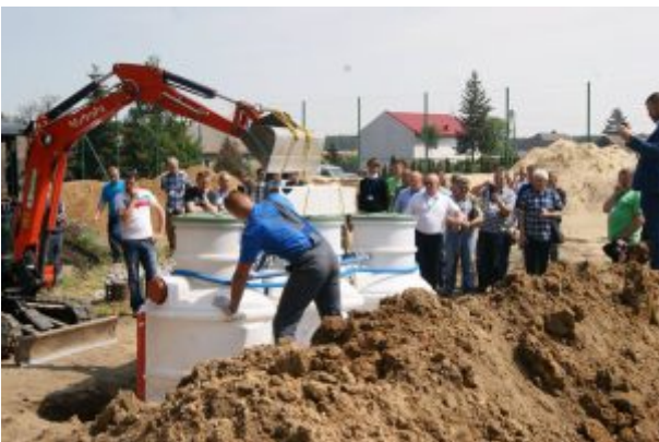
Szkolenie z zakresu montażu oczyszczalni przydomowej
