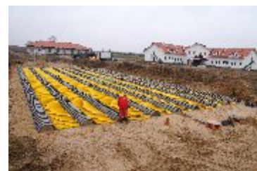
Tunelowy system rozczyszczania HABA przy hotelu dla 60RLM (2006r.)
