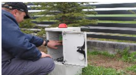
Weryfikacja nastaw sterownika
