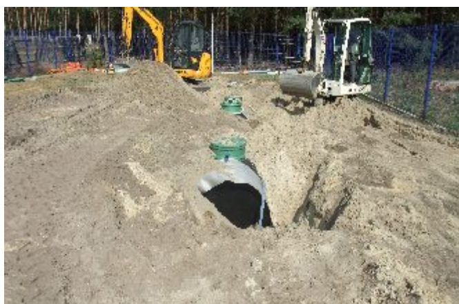
Oczyszczalnia SBR Primo+ dla zakładu produkcyjnego dla 300 pracowników
